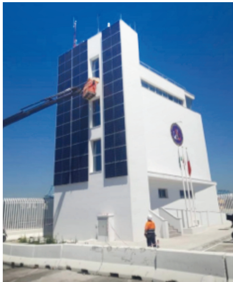
Above: Estación de prácticos de Algeciras. Fuente: Corporación de Prácticos de Algeciras
